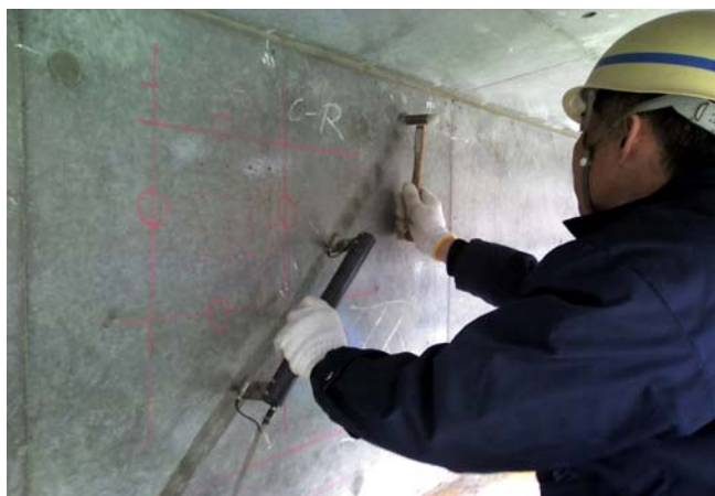
橋梁上部工桁側面の測定状況
